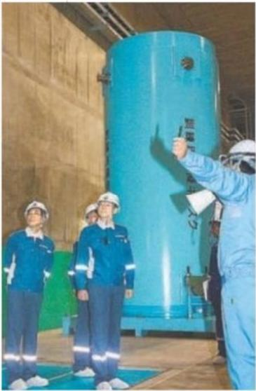
サイクル燃料貯蔵(RFS)の担当者から説明を受け、敷地の形状や各建屋の配置などを確認。貯蔵建屋の内側では、実物と同サイズの模擬キャスク(高さ5・4m、直径2・5m、重さ120t)を視察し、貯蔵区域のキャスク容量や固定方法などを確かめた。
