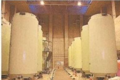
東電も震災前から福島第1原発(福島県)に乾式貯蔵を導入しており、被災時でもキャスクに大きな問題は生じなかった。乾式貯蔵は燃料の冷却に電気も水も使わずに、安全性が高いとされ、原子力規制委員会の更田豊志委員長は「同じ量が原発サイト内にとどまるなら、冷却の進んだ燃料は速やかに乾式に移すべきだ」と主張している。
