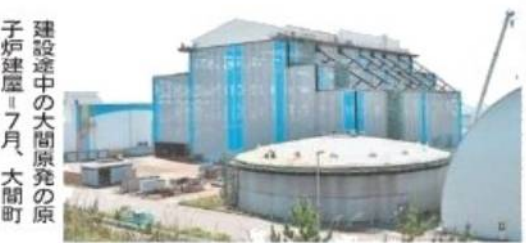
建設中の大間原発の原 子炉建屋。7月、大間町
