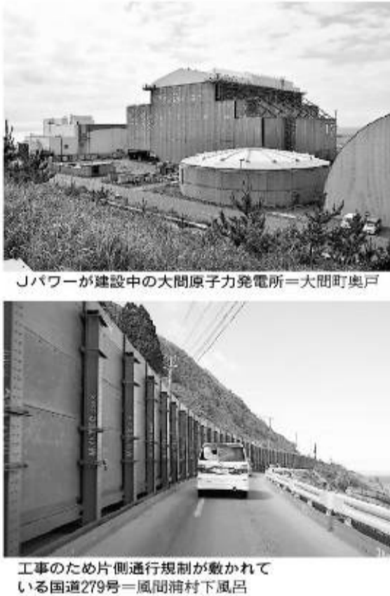
Jパワーが建設中の大間原子力発電所＝大間町奥戸
