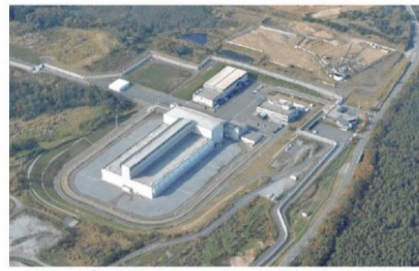
安全協定が締結され、9月中の事業開始が見込まれる中間貯蔵施設
