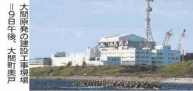
大間原発の建設工事現場。9日午後、大間町奥戸
